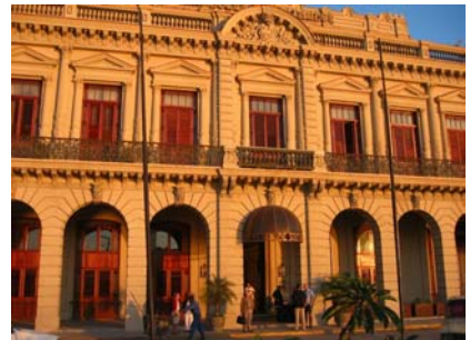
Hotel Santandor de Armadores
